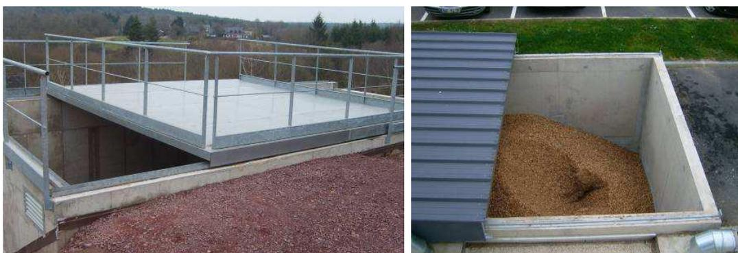
Le silo est en général dimensionné suivant l'autonomie à pleine charge de la chaudière souhaitée (généralement de 3 à 5 jours).
